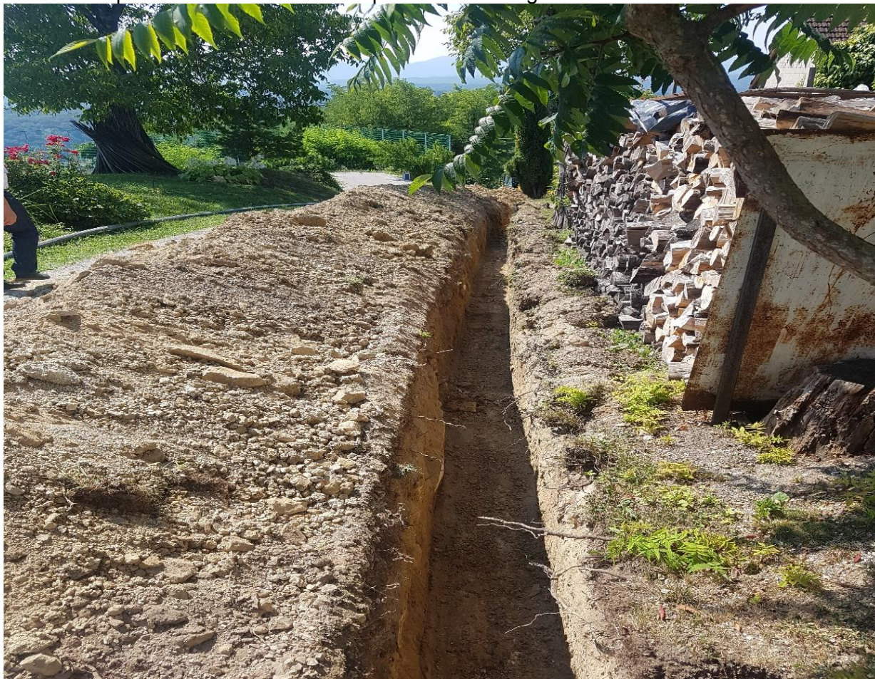
Slika 7. Iskop rova - sekundarna mreža podsustava Vinagora
