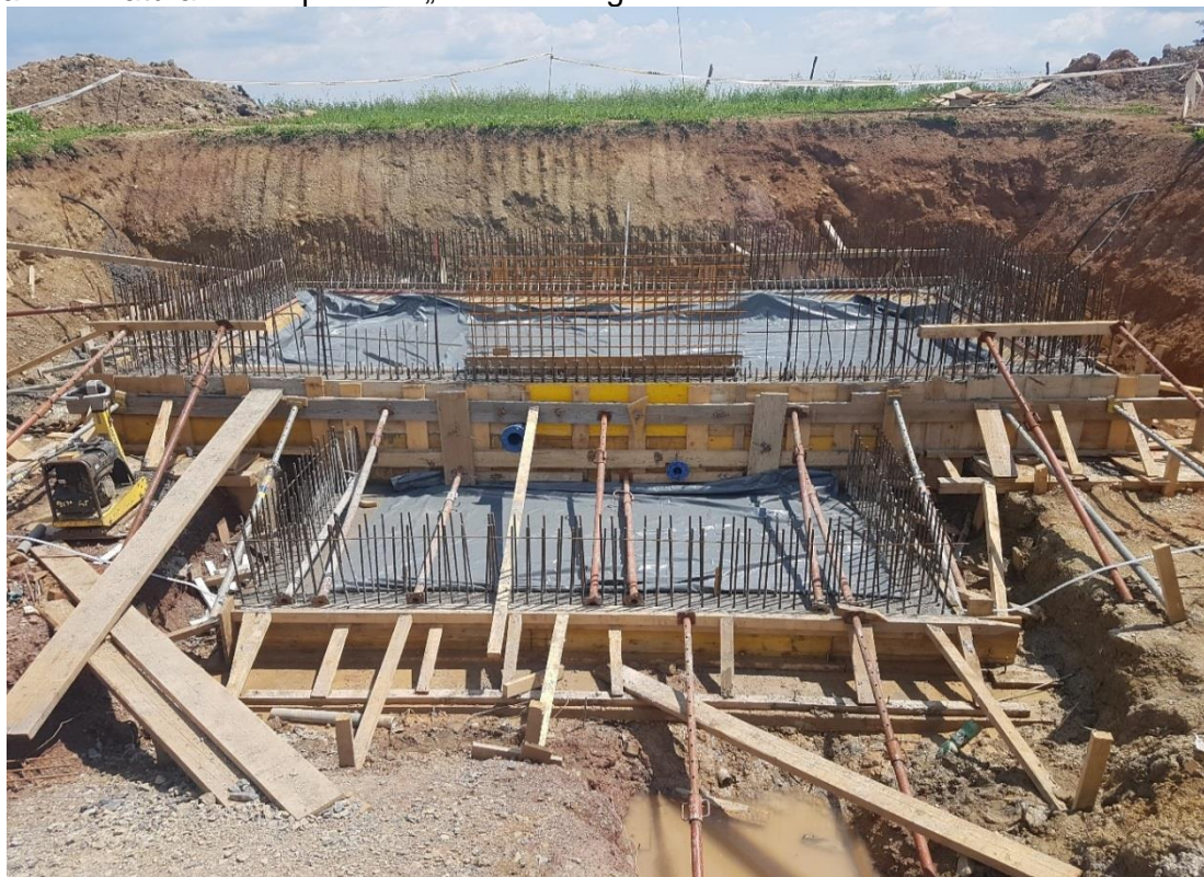
Slika 2. Armatura- vodospremnik „Žolekov Breg“
