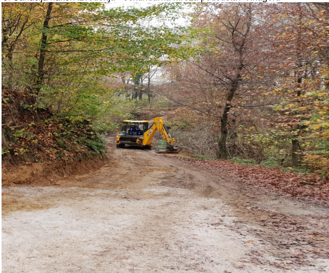
Slika 9. Sanacija nakon izvođenja - sekundarna mreža podsustav Vinagora
